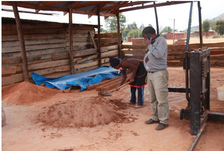
Foto 10 miscelatura di terra, sabbia e cemento, con aggiunta di acqua
