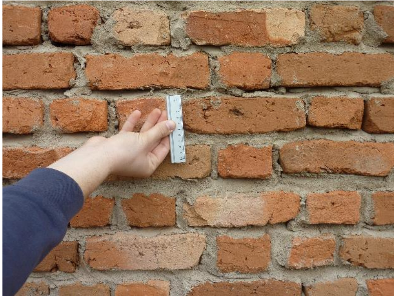
Foto 8, molto cemento tra un corso di mattoni e l'altro
