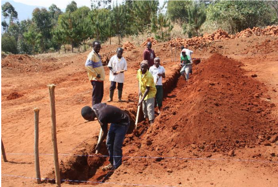
foto 21, scavo delle fondazioni dell'asilo
