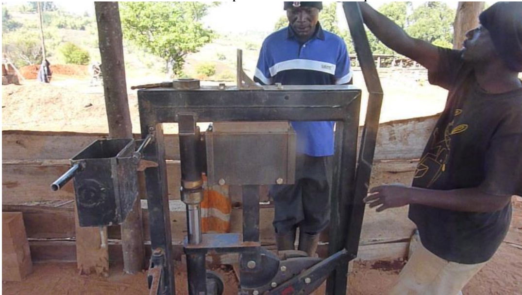
Foto 13 spostamento nel portale di pressatura
