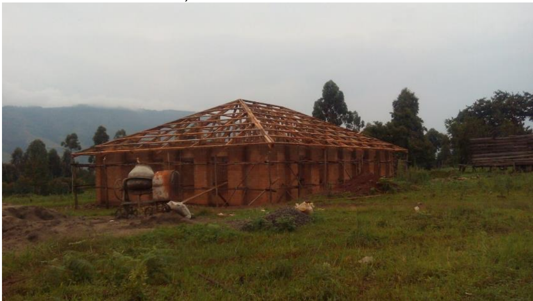
foto 25, la costruzione dell'asilo a Mkiu
