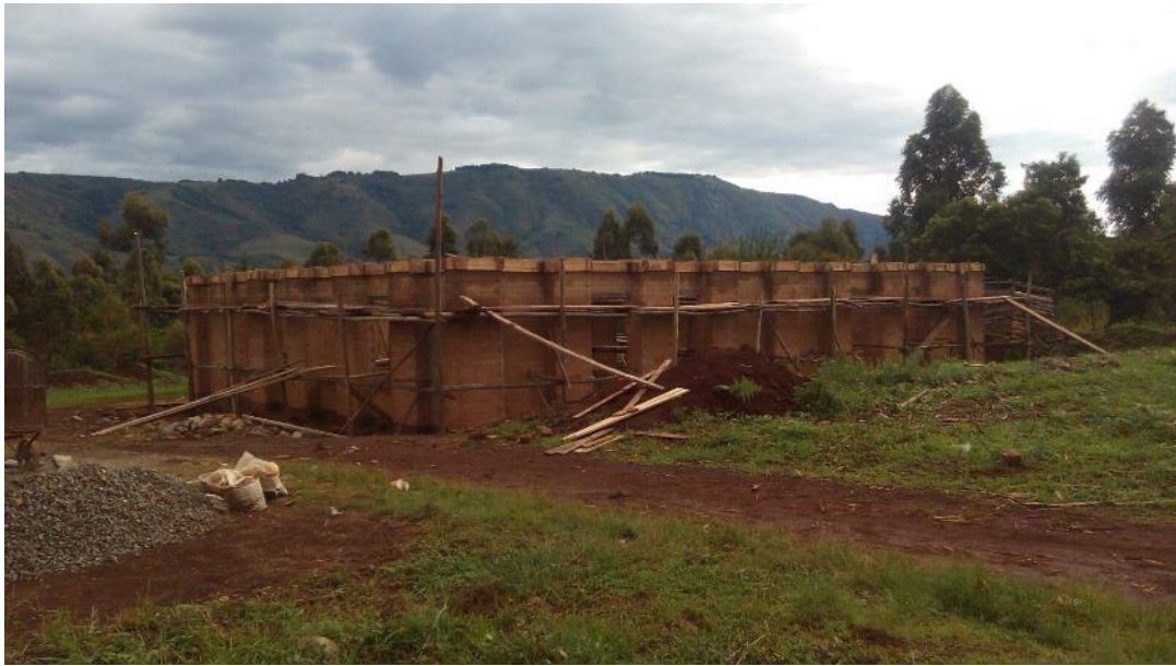
foto 24, la costruzione dell'asilo a Mkiu
