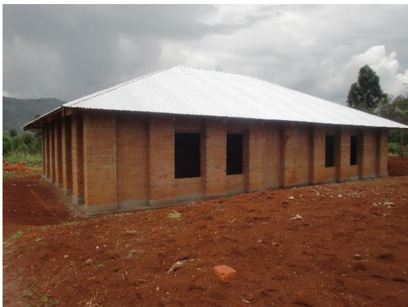
foto 26, la costruzione dell'asilo a Mkiu
